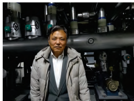
阪大サイバーメディアセンター階下冷却装置室にて
